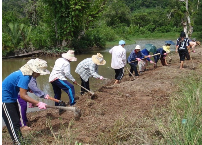
Figura 6: Los aldeanos allanando de nuevo la dique del estanque de camarones para aumentar el área donde los manglares crecerán
